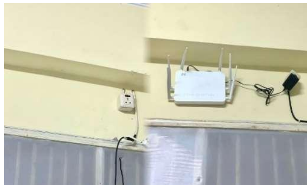
Gambar 5. Pemasangan Acces point pada ruangan
