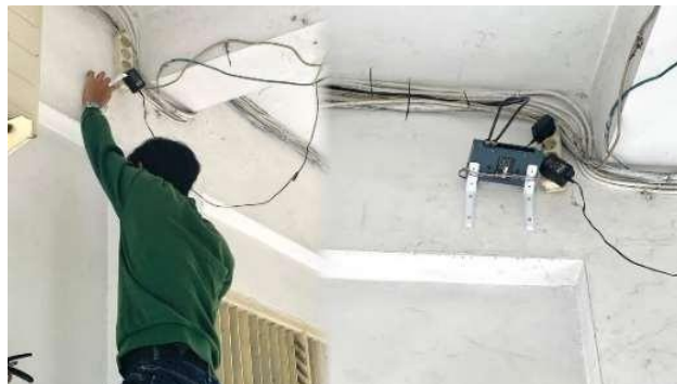
Gambar 4. Pemasangan Switch Hub posisi pada plafon teras ruang kelas 1.2
