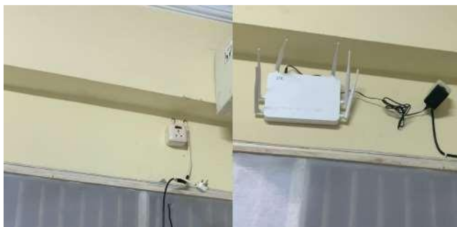
Gambar 6 . Hasil Pemasangan di Ruang Aula
