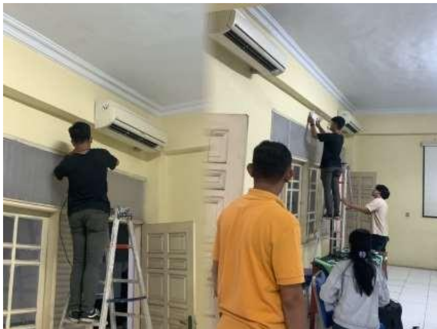
Gambar 5. Pemasangan Router Di Ruang Aula
