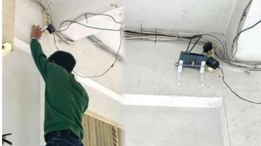
Gambar 2. Pemasangan Router di Depan Ruang AULA
