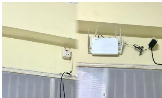
Gambar 5. Pemasangan Acces point pada ruangan
