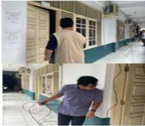
Gambar 3. Pengukuran dan Pemasangan Kabel LAN
